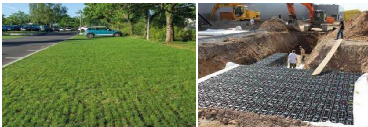
Exemple de stationnement perméable et de bassin de rétention sous voirie. Source : Source : Rebeyrol Architectes.
