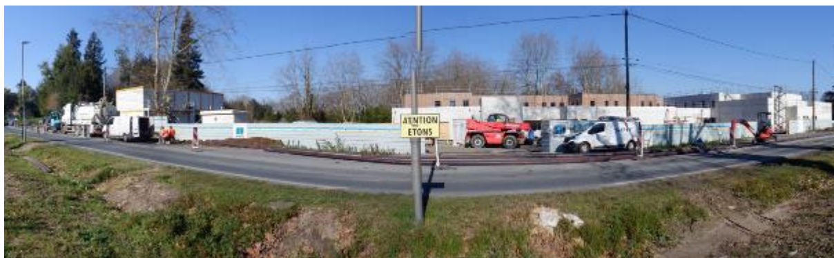
Vue sur le chantier de construction du CORPB (février 2023). Source : APGL.
